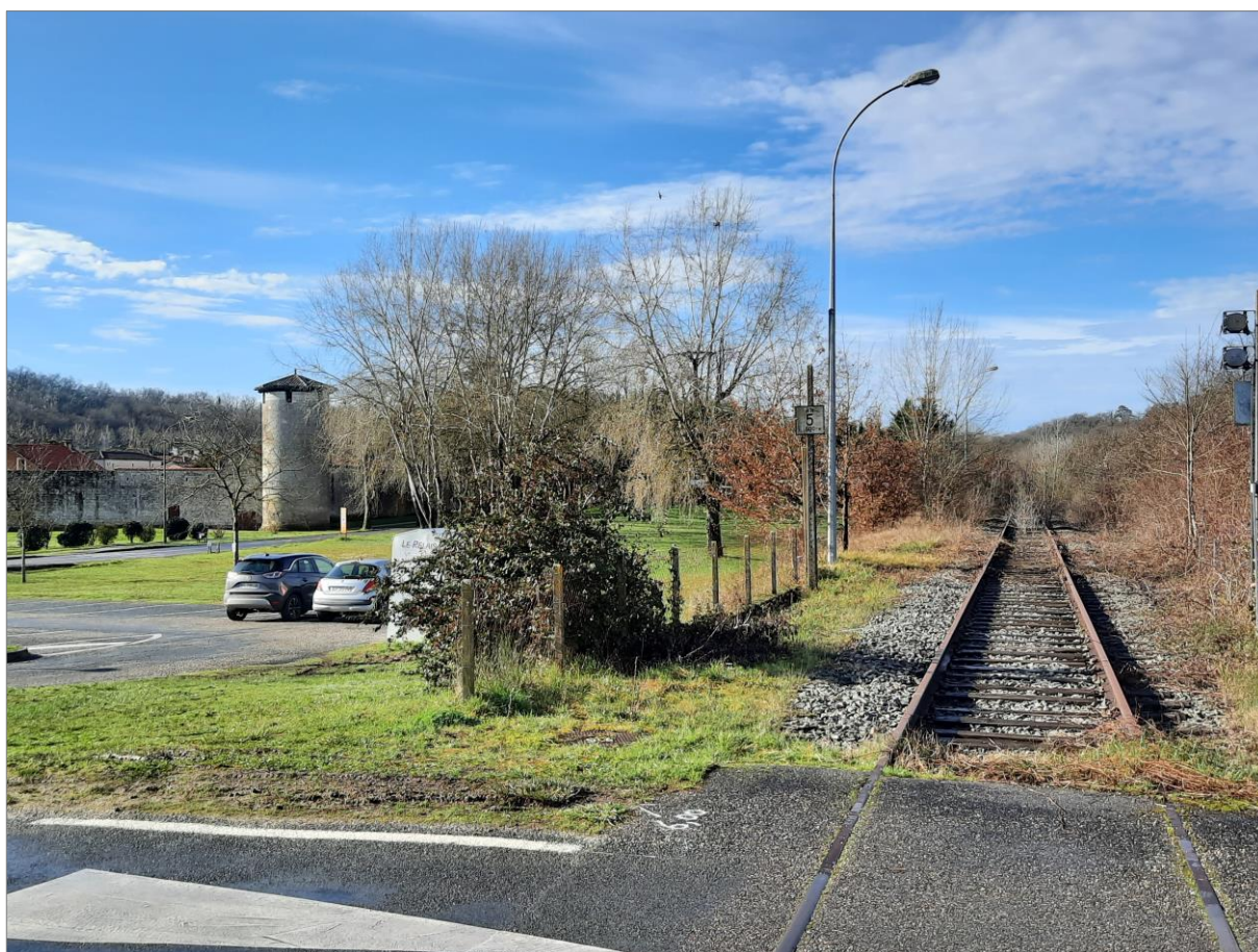
Figure 20 : Vue sur la ville fortifiée de Vianne et sur la ligne n°643.000 (Source : SNCF Réseau)
