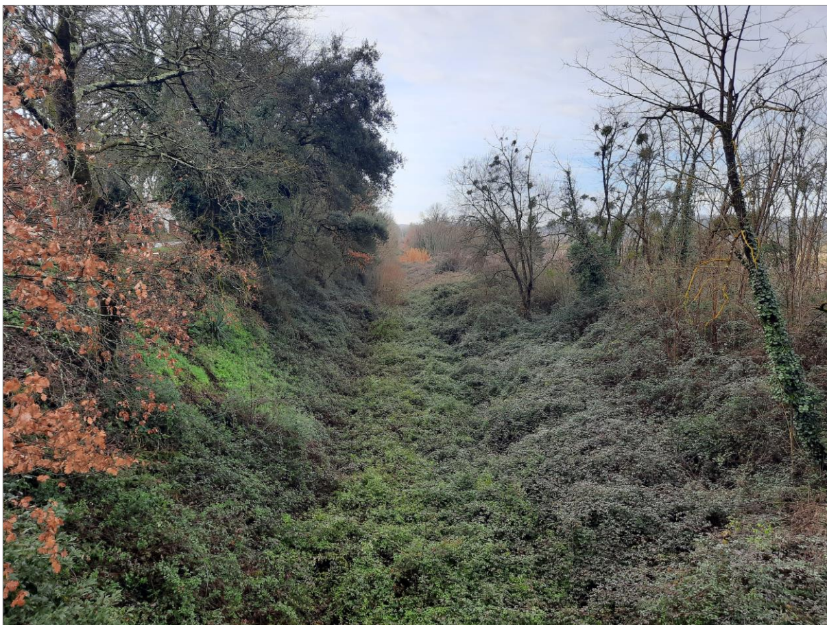
Figure 17 : Vue sur les emprises de la ligne n°643.000, à Feugarolles (Source : SNCF Réseau)
