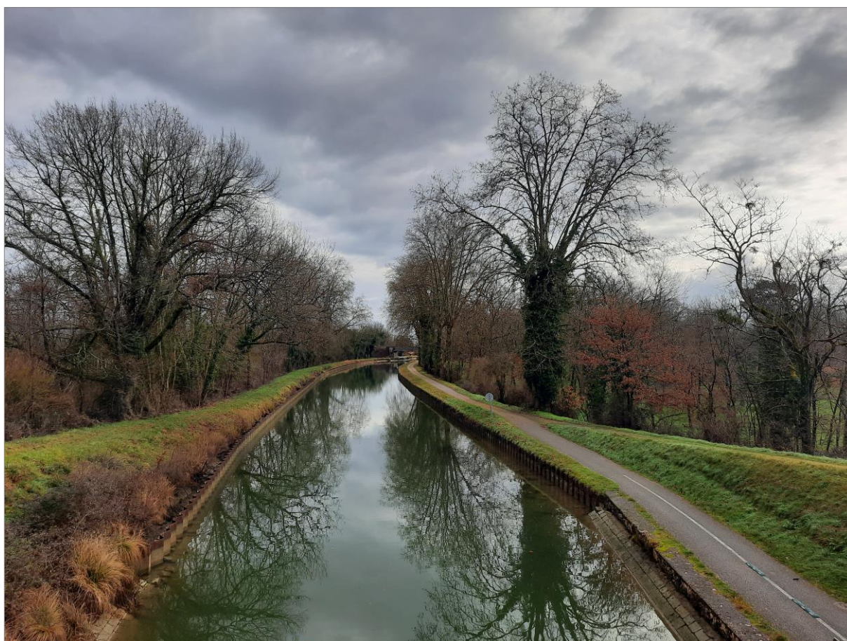
Figure 6 : Voie verte V80, Canal latéral de la Garonne, Feugarolles (Source : SNCF Réseau)
