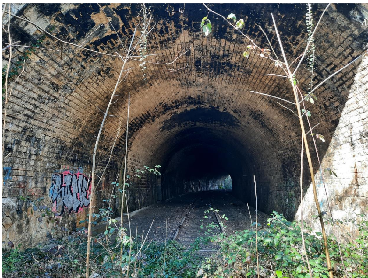
Figure 21 : Vue dans le tunnel de Nérac, ligne n°643.000 (Source : SNCF Réseau)
