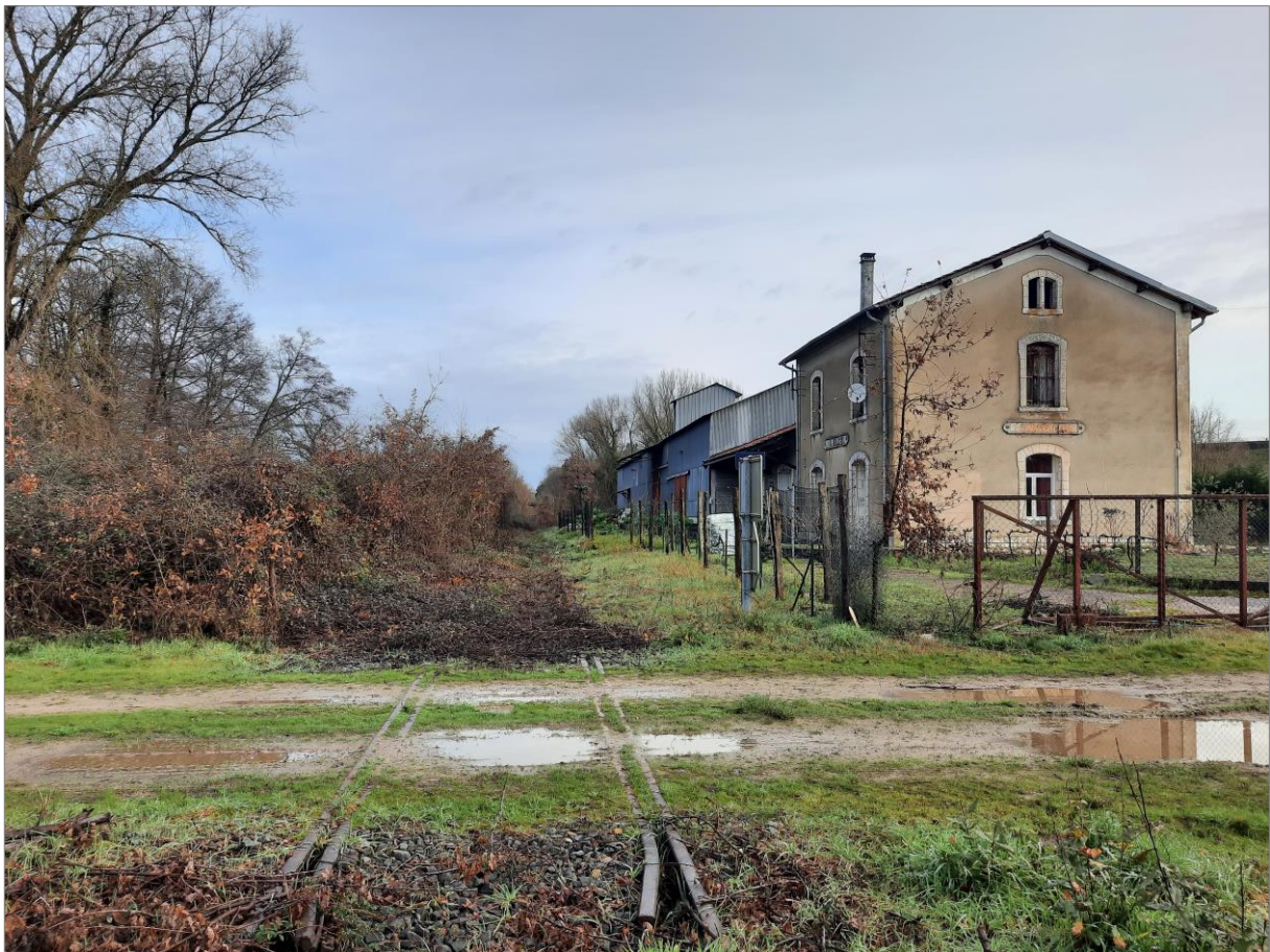
Figure 10 : Vue sur l'ancienne gare de Feugarolles, ligne n°643.000 (Source : SNCF Réseau)
